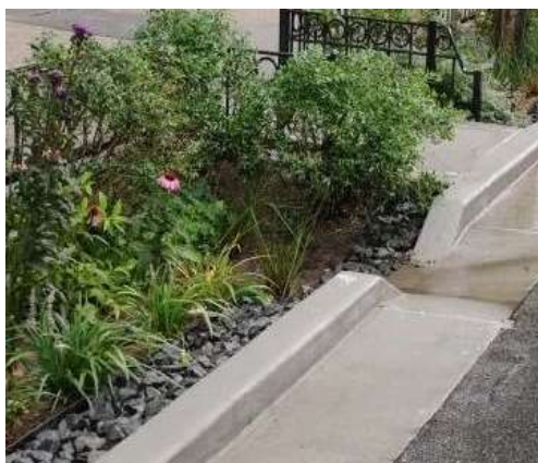
Впускное отверстие для приёма ливневых вод с тротуара
