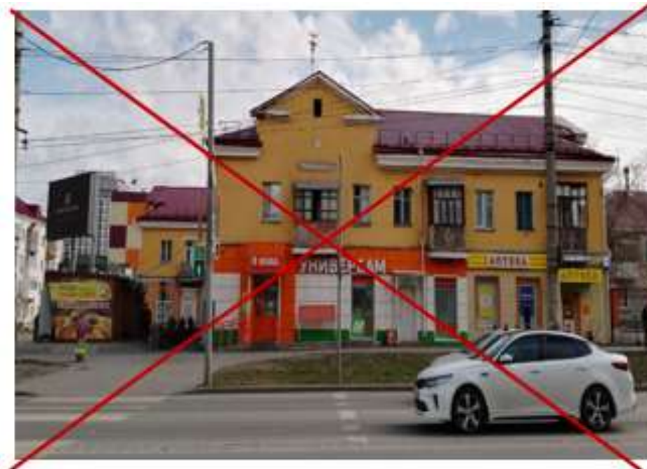
Фрагментарная отделка фасада
