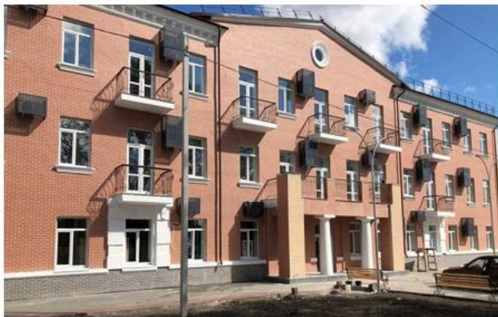
Пример правильного размещения кондиционеров на фасаде
