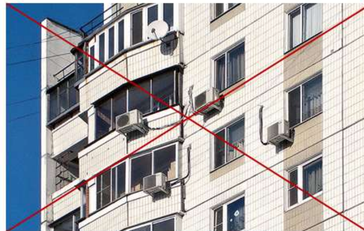
Пример НЕ правильного размещения кондиционеров на внутридворном фасаде
