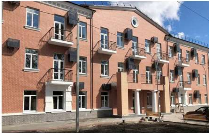
Пример правильного размещения кондиционеров на фасаде
