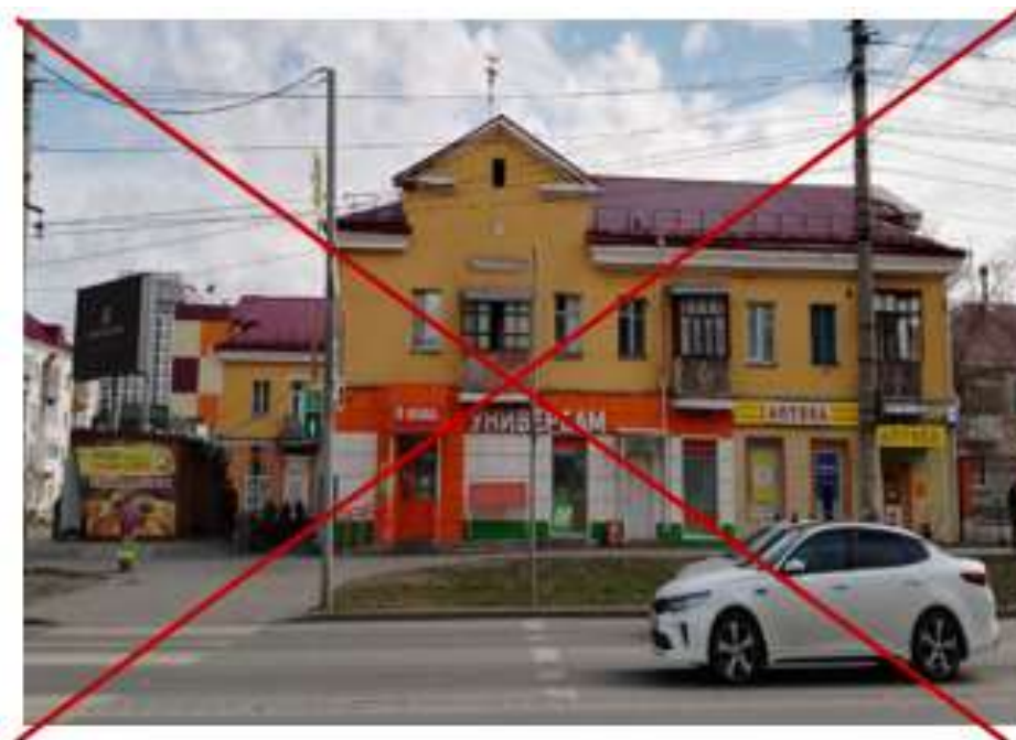
Фрагментарная отделка фасада
